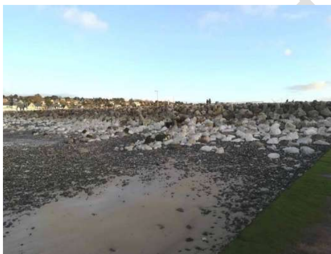
Figure 23 : protection en enrochement située à l'ouest (photo CEREMA 2017)
