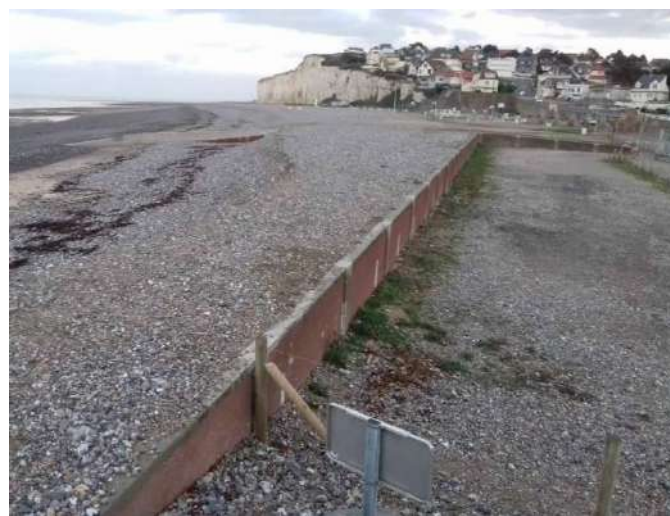
Figure 24 : mur de soutènement entre les épis 0 et 1 (photo CEREMA 2017)
